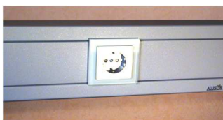
Widok odcinka kanału BRS
