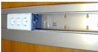
Widok odcinka kanału BRE.
