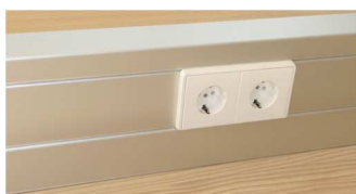
Widok odcinka kanału BRA.
